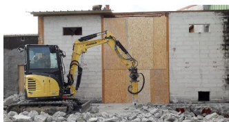
Façade nord démolie
