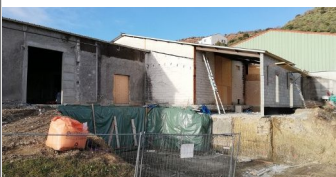
Fondations au nord
